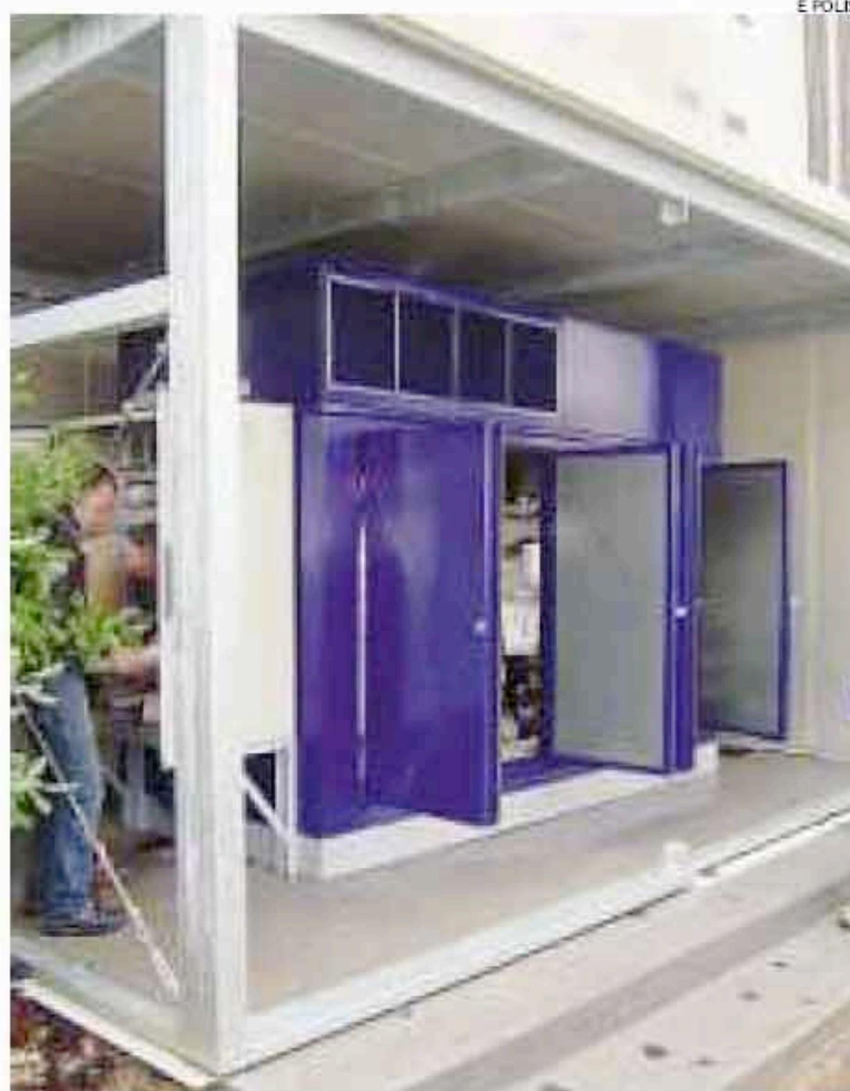
► Foto impianto cogenerazione - fonte: Baronchelli
